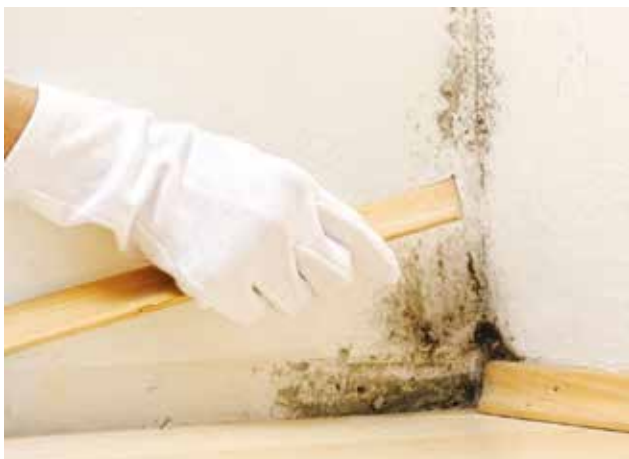
Parfois bien visibles, les moisissures peuvent aussi être cachées derrière une plinthe par exemple.
